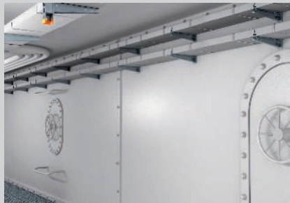
Utilização de envoltura em ambientes agressivos, por exemplo em instalações offshore.
