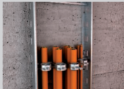
Fixação de cabo individual ou Conjunto de cabos com abraçadeiras BBS.
