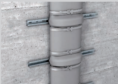
Fixação da envoltura numa instalação com perfis.
