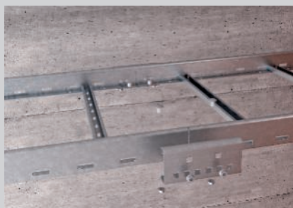
Instalação de união reta com parafusos de cabeça boleada.
