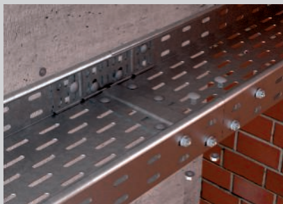
Fixar o conjunto de uniões retas e réguas tapa juntas com parafusos de cabeça boleada.
