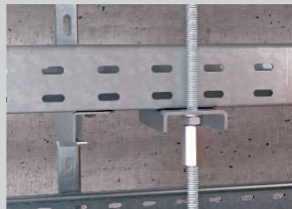
Fixação do varão roscado na esteira com disposição multinível.
