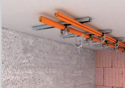
Instalação de cabos, individual ou em Conjunto.
