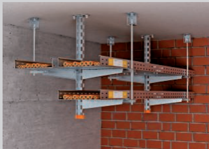
Suspensão no teto com disposição da consola nos dois lados.
