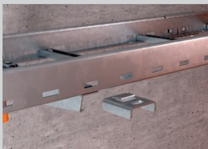
Encaixe do suporte de suspensão na secção inferior do perfil lateral da escada.
