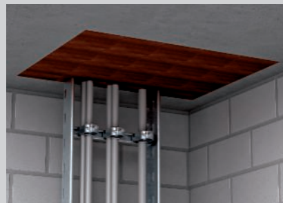
Montagem bem assente dos blocos na abertura no teto.
