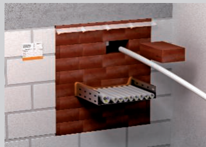
Instalação posterior simplificada retirando todo o bloco para fora.
