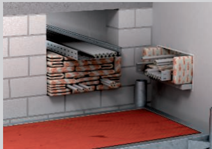
Fecho das aberturas com almofadas - sem massa de revestimento ou pintura.
