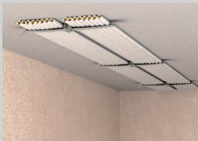
Montagem ao teto com abraçadeira de teto 2033 M.
