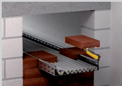
Montagem de blocos seccionados.
