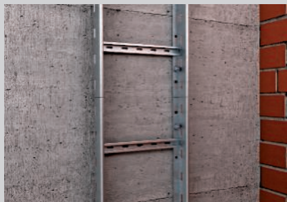
Instalação direta da escada vertical em parede sólida.
