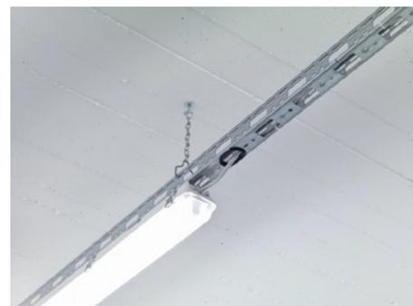
Exemplo de instalação de luminária na Eletrocalha AZ.
